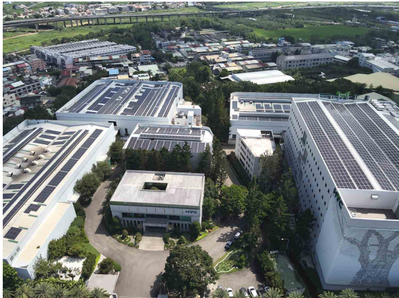
圖示：廠區屋頂鋪設太陽能 總建置容量達1,900Kwp
