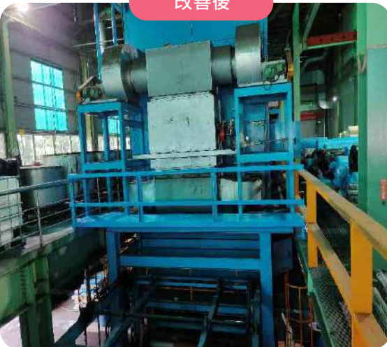
圖示 | 改善後:改設置護欄
