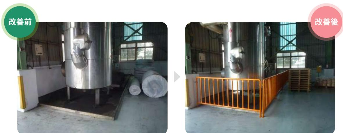
圖示 | 改善前：熱媒槽區未設置護柵
